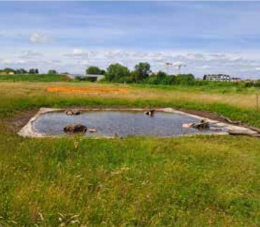
À fond en béton et étanches, elles permettent de retenir l'eau de pluie. **C'est une première dans le Grand Est !**
